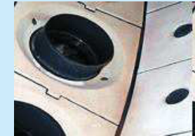
widok wnętrza komory spalania z palnikiem
