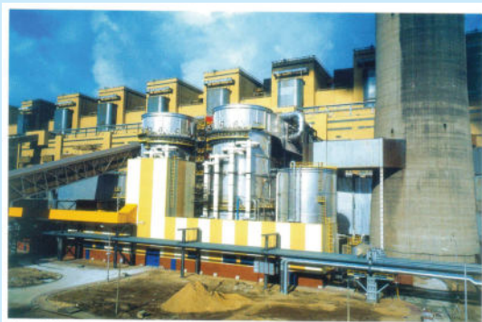
Elektrownia Belchatów - instalacja odsiarczania dla bloków 5 i 6
